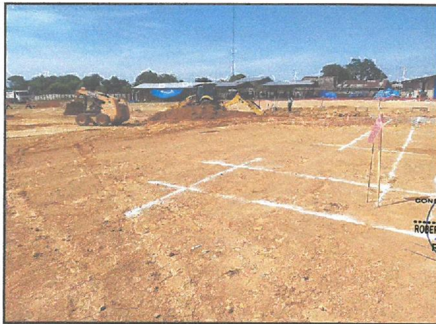
En la vista se aprecia el realizado de nivelación, trazo y excavación del Sector A bloque 1
