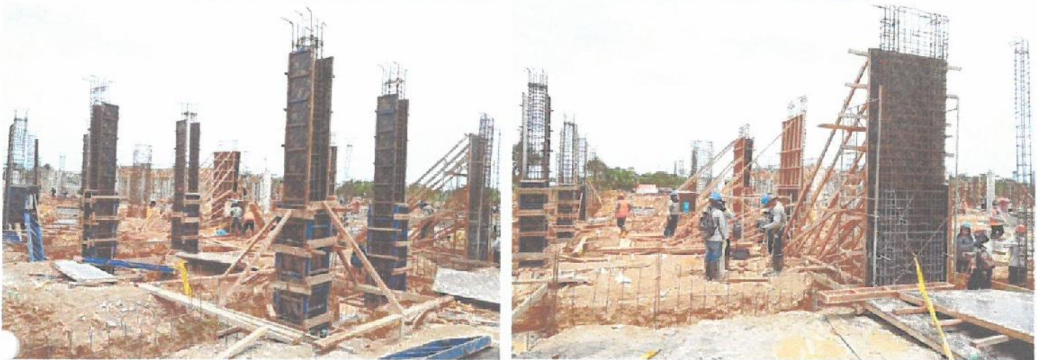
Encofrado de columnas y placas en el Bloque A-1.
