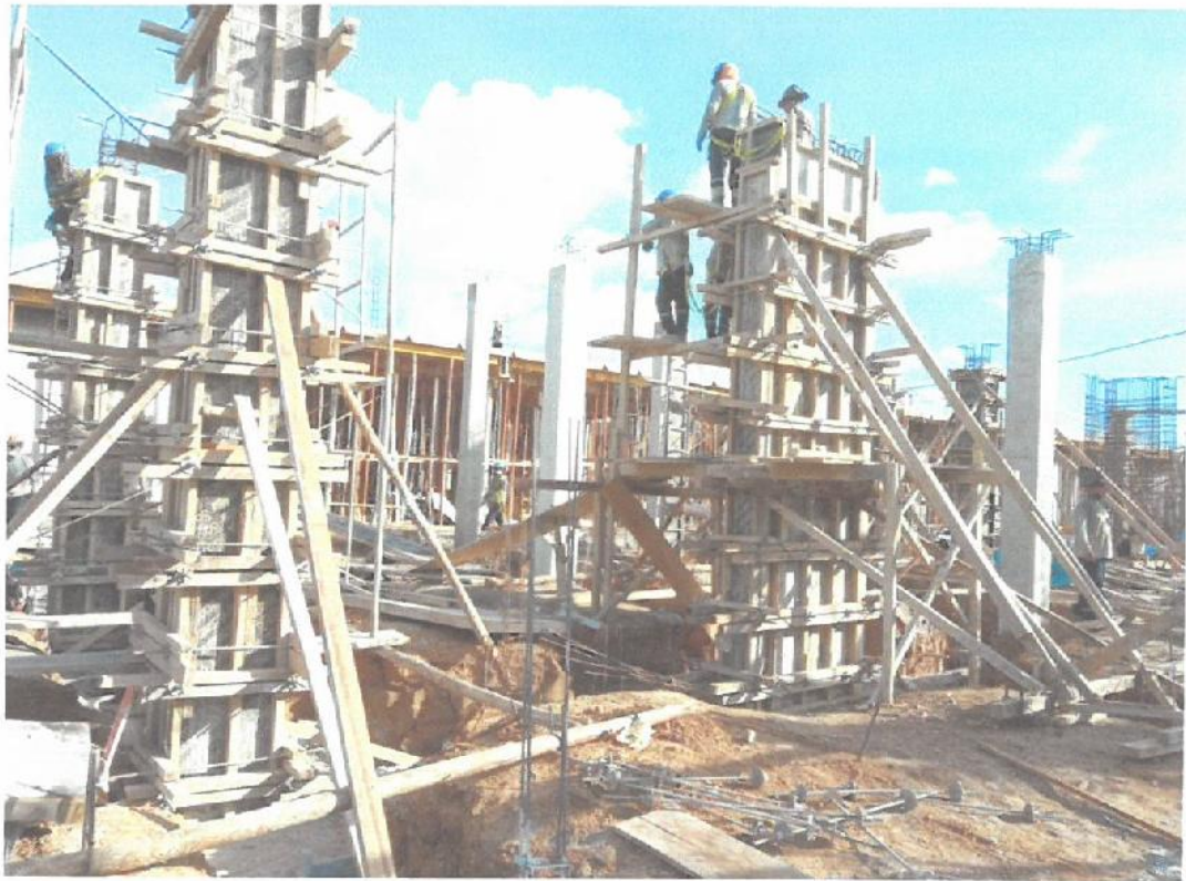
Fotografía N° 11: Encofrado y vaciado de concreto en columnas y placas del módulo F-1.
