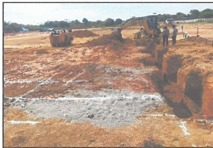
En la vista se aprecia, la excavación de zapatas y cimientos en el Sector D bloque 1
