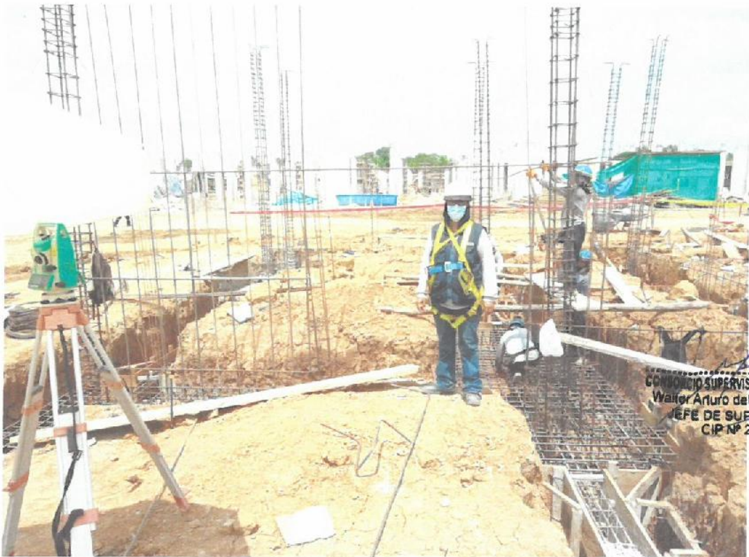
Fotografía N° 06: Colocación de acero en zapatas y vigas de cimentación en el Módulo E-3.
