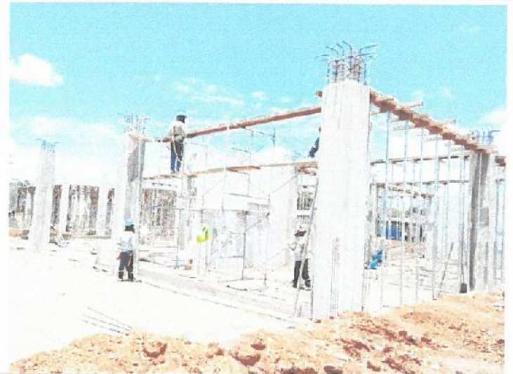
Encofrado de fondo de vigas peraltadas para losa aligerada en el Bloque D - 1ª Parte.
