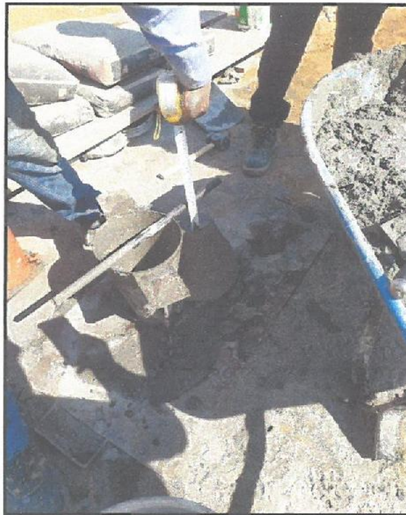
En la vista se aprecia, la realización de la prueba de asentamiento (slump), para el vaciado de zapatas y vigas de cimentación en Sector D bloque 1
