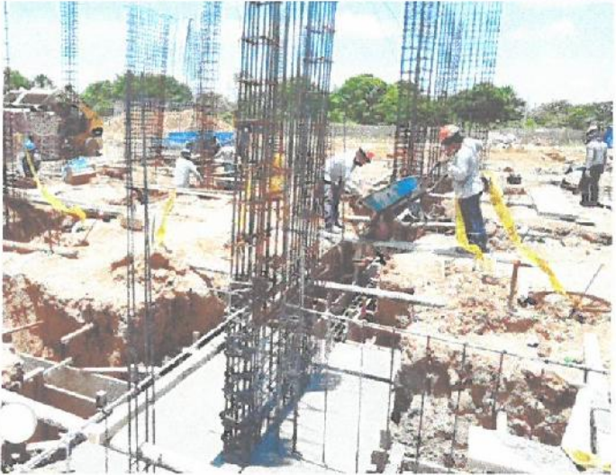
Vaciado de concreto f_c = 210 \text{ Kg/cm}^2 en zapatas y vigas de cimentación en el Bloque C-1.
