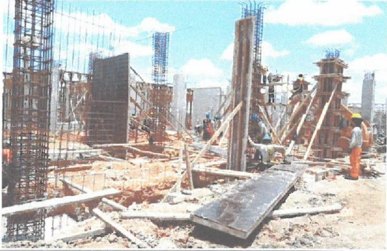
Encofrado de columnas y placas en el Bloque B-1.
