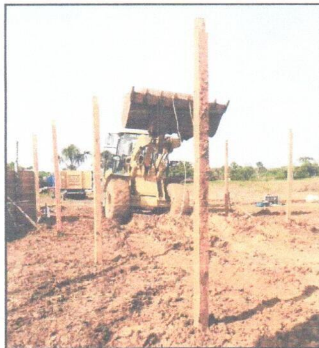
En la vista se aprecia, la colocación de columnas de madera, para el techo del almacén.
