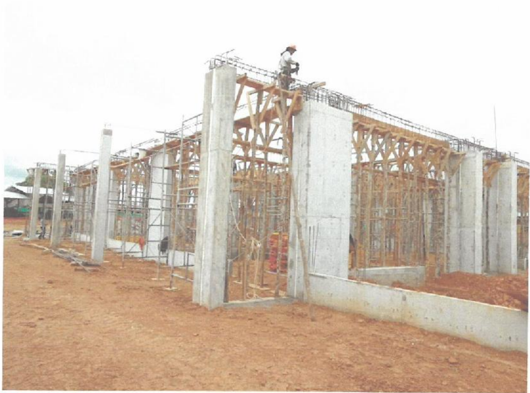
Fotografía N° 07: Encofrado de fondo de vigas peraltadas para losa aligerada en Módulo A-1.
