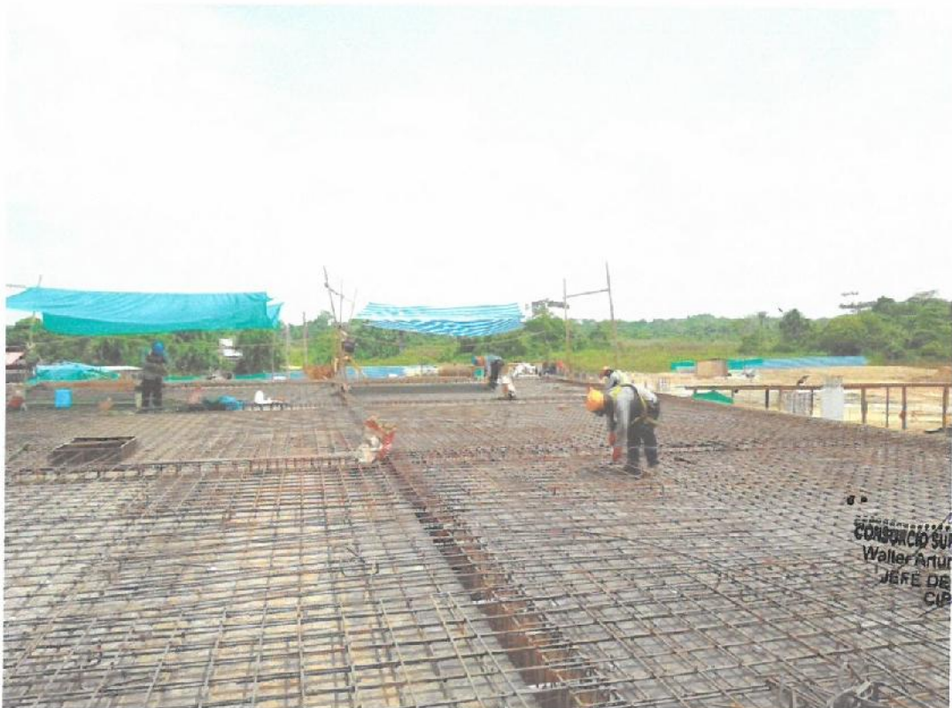
Fotografía N° 04: Colocación de acero en vigas peraltadas y losa maciza en el Módulo D.
