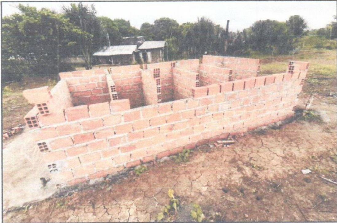
En la vista se aprecia, la realización de los servicios higiénicos provisionales.
