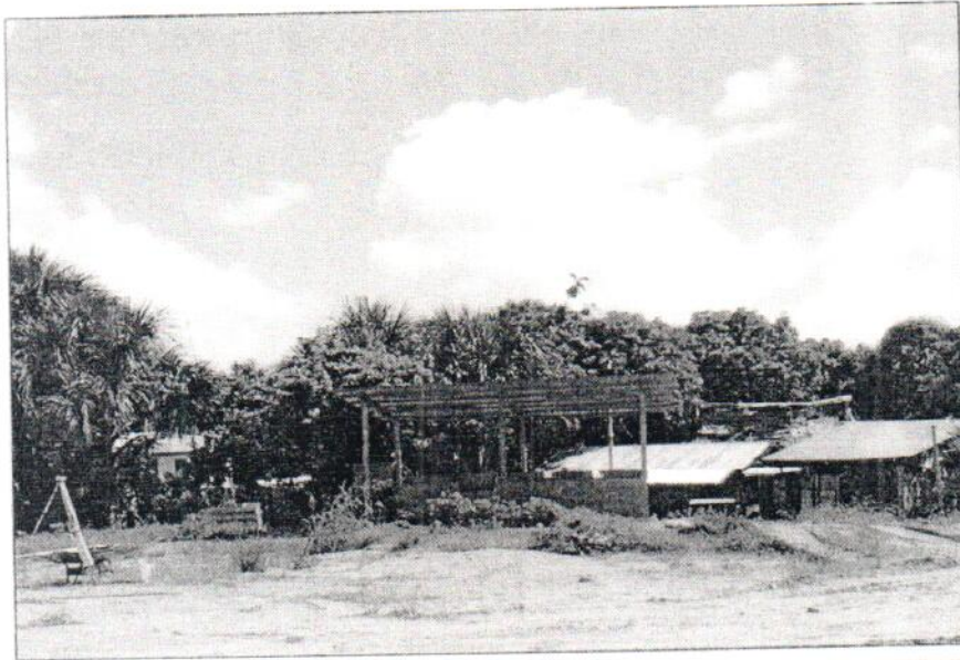
Foto N° 04: Se puede apreciar en construcción los servicios higienicos provisionales.
