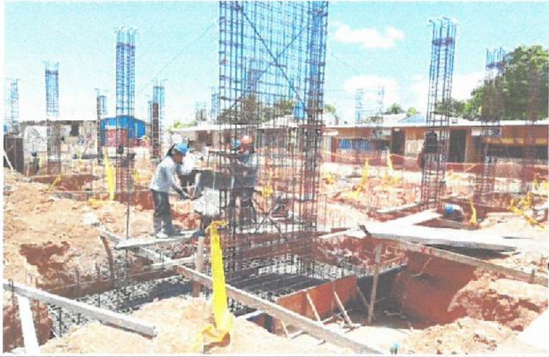
Vaciado de concreto en zapatas y vigas de cimentación en el Bloque A-1.
