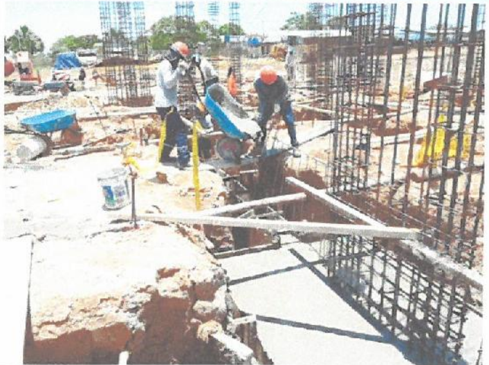
Vaciado de concreto f_c = 210 \text{ Kg/cm}^2 en zapatas y vigas de cimentación en el Bloque C-1.
