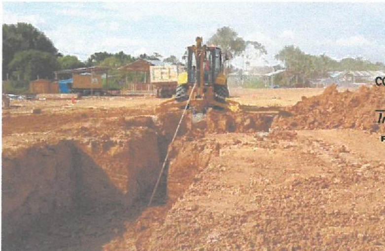
Excavación de zanjas con fines de cimentación con retroexcavadora en el Bloque A-1
