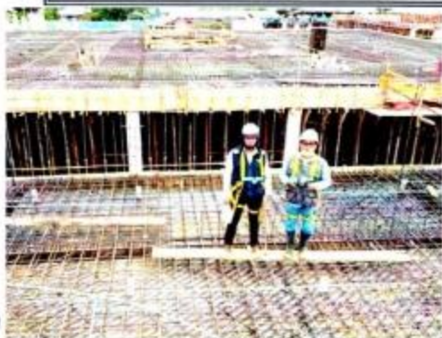
Liberación de losa maciza para vaciado de concreto F_c = 210 \text{ Kg/cm}^2 en Módulo D.
