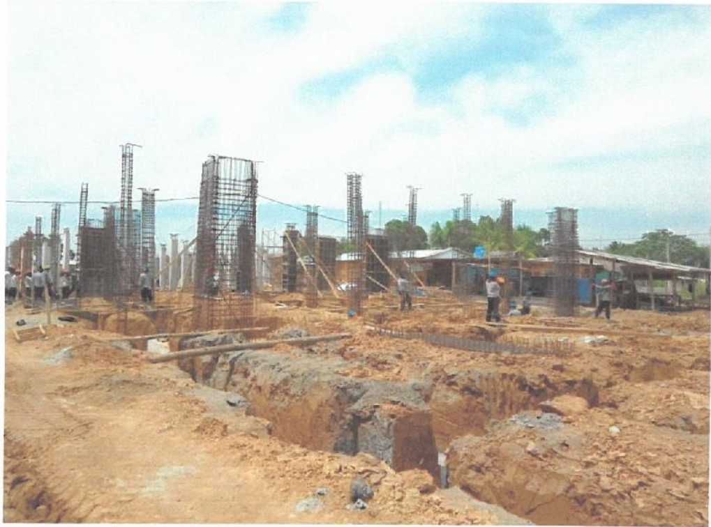
Fotografía N° 01: Izaje de columnas y placas en el Módulo A-1 (Bloque N° 05).
