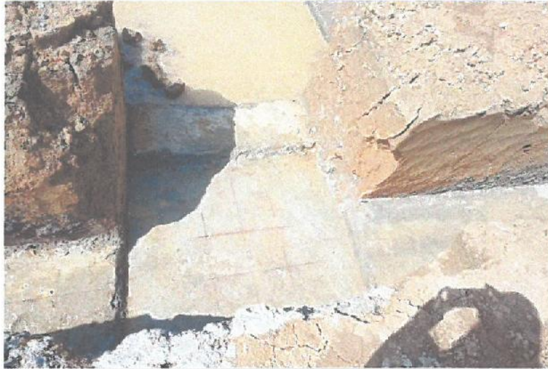
Trazo de columna sobre solado de zapata en el Bloque D.
