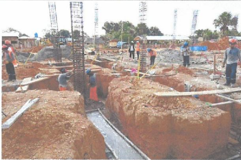
Izaje de columnas sobre armadura de zapatas en el Bloque B-1.
