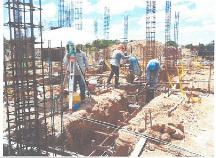
Vaciado de concreto en zapatas y vigas de cimentación en el Bloque C-1.
