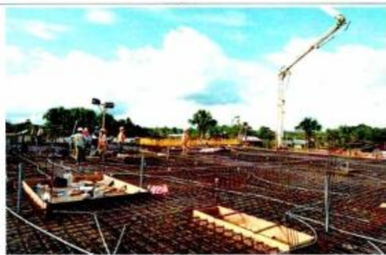
Vaciado de concreto f_c = 210 \text{ Kg/cm}^2 de losa maciza en Módulo D.
