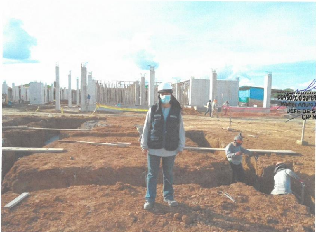
Fotografía N° 12: Excavaciones de zanjas para inicio de trabajos en Módulo E-1.
