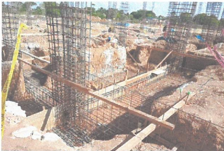
Habilitado de acero estructural en Zapatas, Columnas y Vigas de Cimentación.
