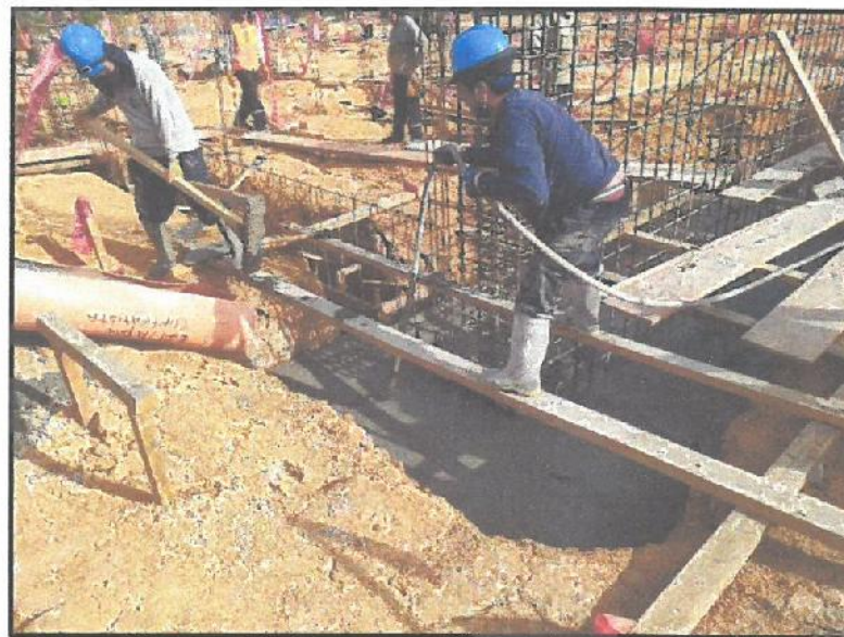
En la vista se aprecia, el vibrado de concreto para su mejor asentamiento, en Sector D bloque 1
