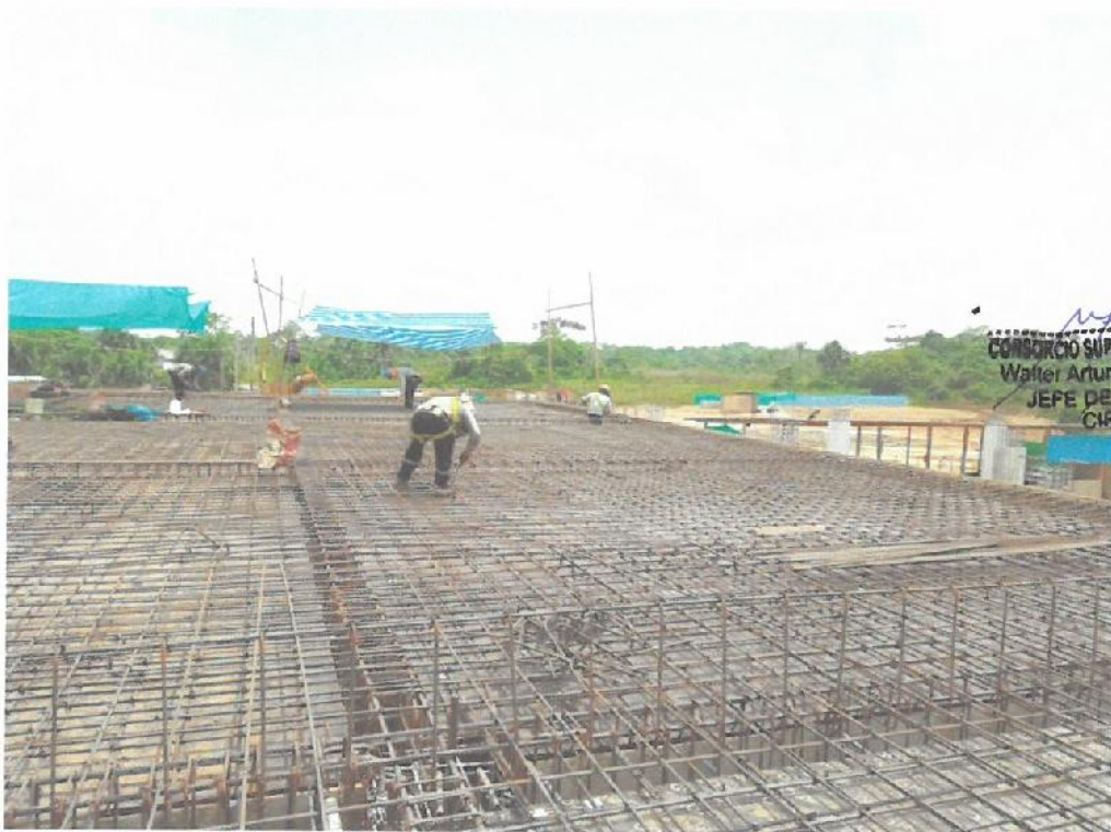
Fotografía N° 02: Colocación de acero en vigas peraltadas y losa maciza en el Módulo D.
