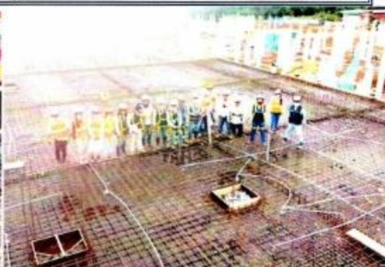
Liberación de losa maciza para vaciado de concreto F_c = 210 \text{ Kg/cm}^2 en Módulo D.
