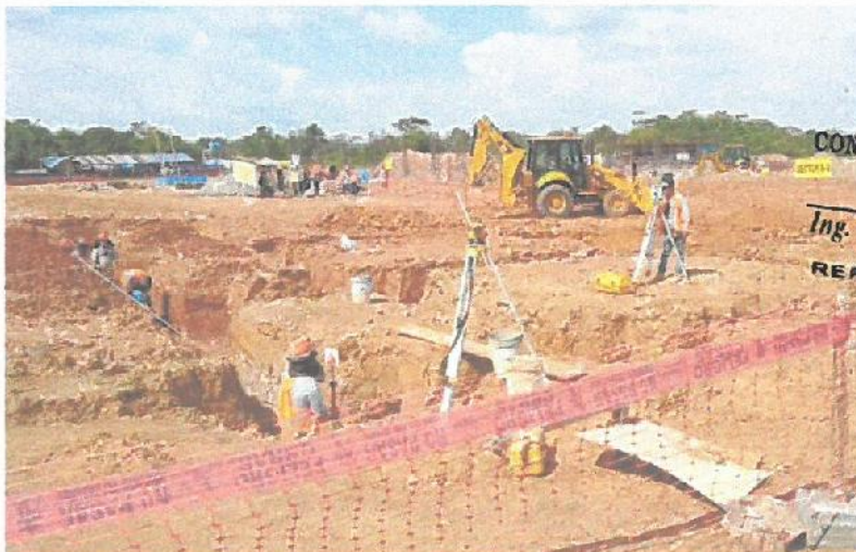
Excavación de zanjas con retroexcavadora y control de niveles con nivel topográfico (Bloque A-1).
