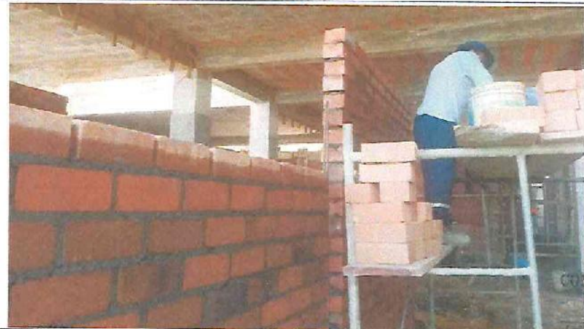
Asetado de Ladrillo King Kong en el Sector A1, Bloque A1.
