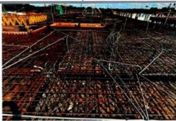
Vaciado de concreto f_c = 210 \text{ Kg/cm}^2 de losa maciza en Módulo D.
