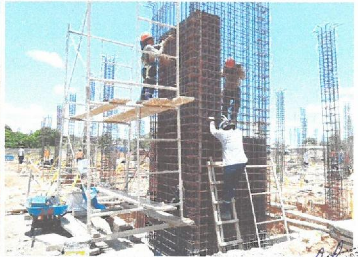
Trabajos de armado de acero en placa y encofrado del mismo en el Bloque C-1.
