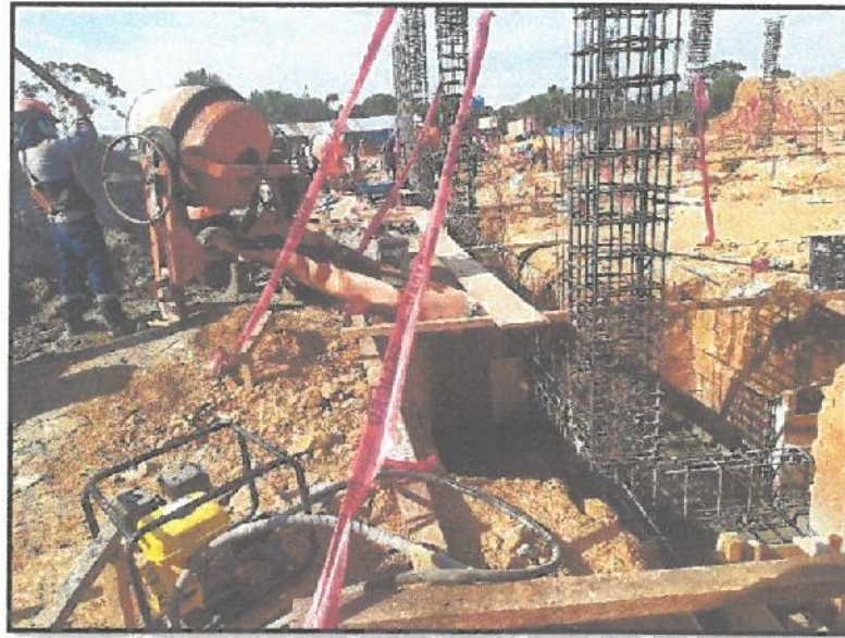
En la vista se aprecia, el vaciado de concreto para zapatas y vigas de cimentación en Sector D bloque 1
