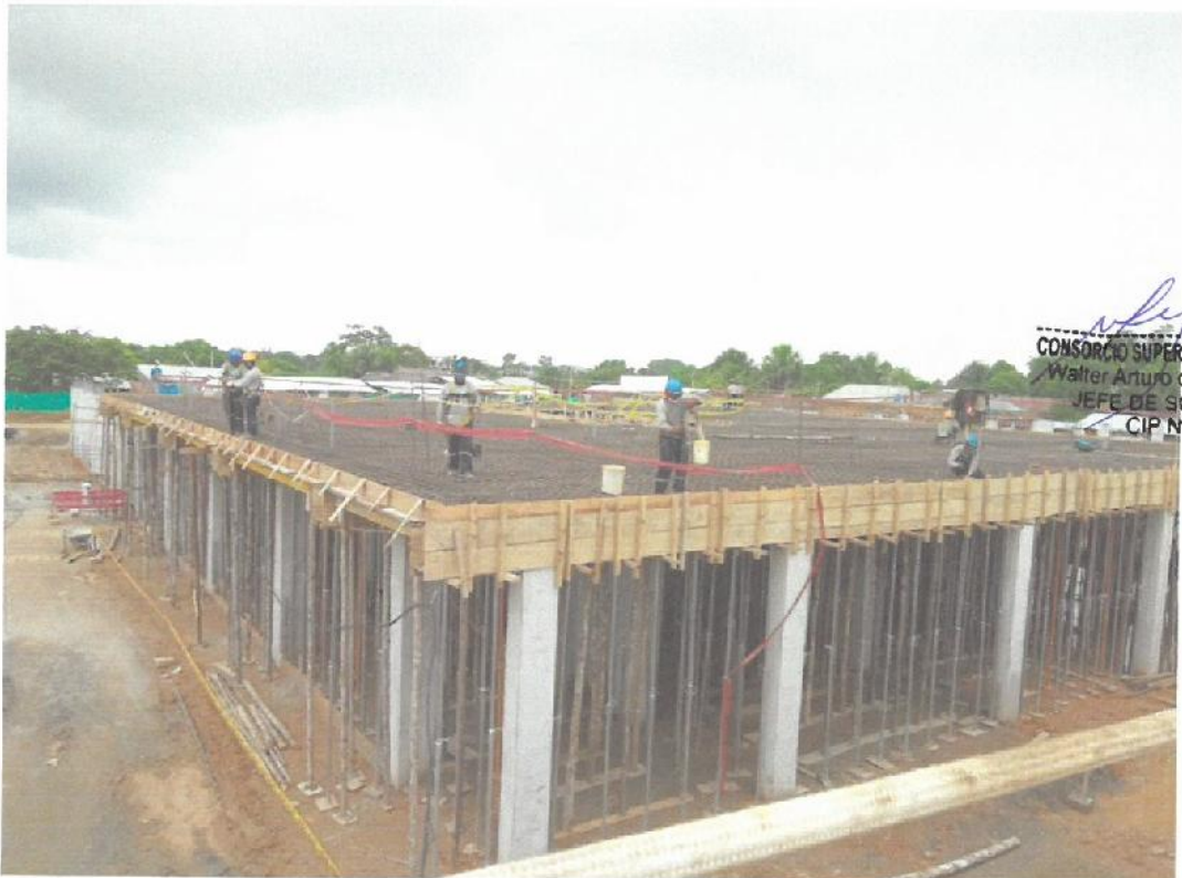
Fotografía N° 10: Colocación de acero en vigas peraltadas y losa maciza en el Módulo B-1.
