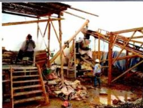
Planta dosificadora de concreto para producción de concreto f_c = 210 \text{ Kg/cm}^2 para losa maciza.
