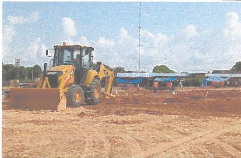
Excavación de zanjas con retroexcavadora y control de niveles con nivel topográfico (Bloque A-1).
