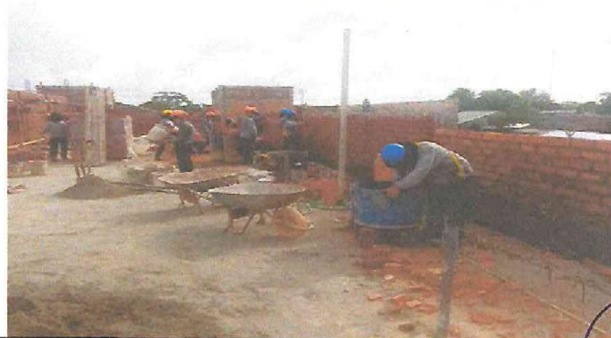
Asentado de ladrillo King Kong en los parapetos del sector A1, Bloque a2.
