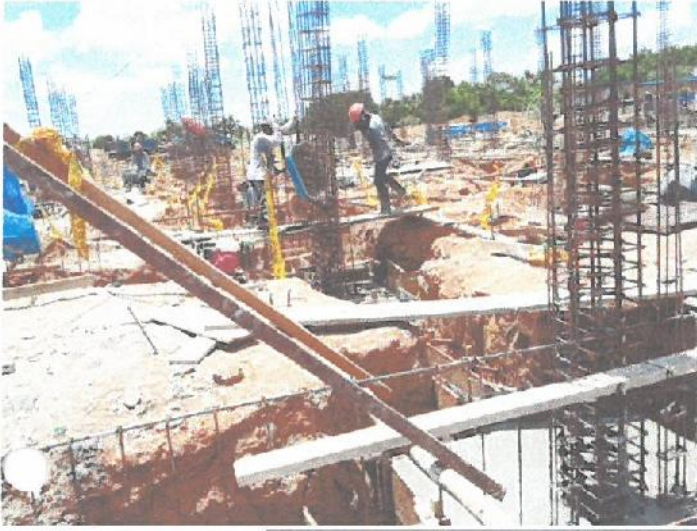
Vaciado de concreto en zapatas y vigas de cimentación en el Bloque C-1.
