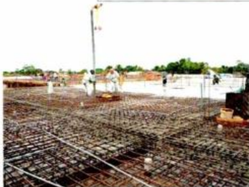
Vaciado de concreto f_c = 210 \text{ Kg/cm}^2 de losa maciza en Módulo D.
