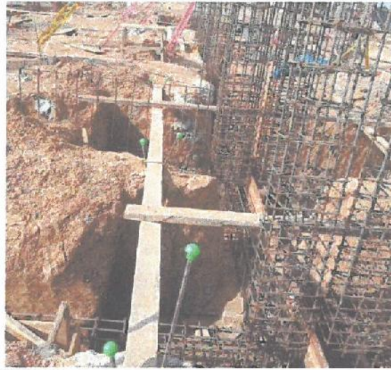
Protección de barras de construcción expuestas (colocación de capuchones de PVC).
