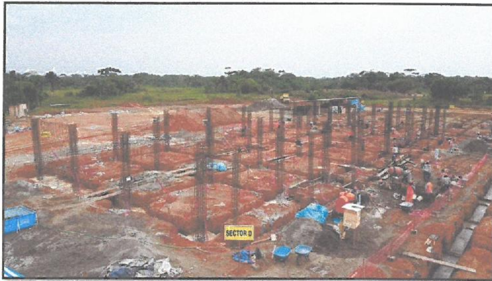
En la vista se aprecia el trabajo general hasta la fecha del Sector D bloque 1, comprendida por excavaciones, solados, vaciado de concreto en zapatas y vigas de cimentación; y la armadura de acero de columnas y sobrecimientos.
