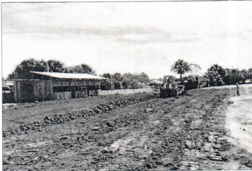
Foto N° 08: Se puede apreciar el corte de material a nivel de Sub rasante con maquinaria.
