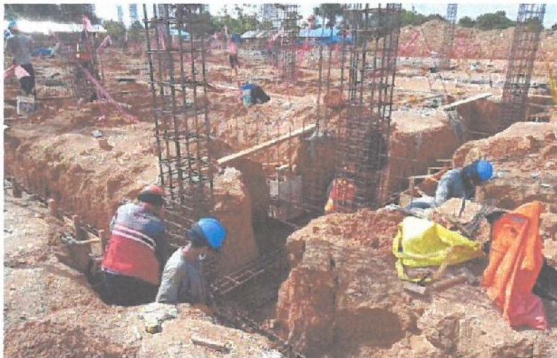
Habilitado de acero estructural para vigas de cimentación (Bloque D).
