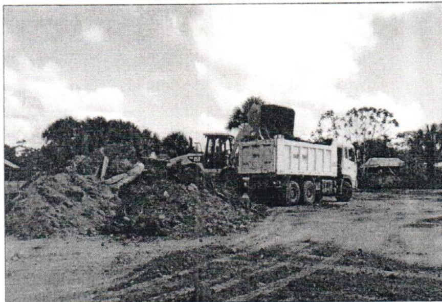
Foto N° 09: Se puede apreciar la eliminación del material excedente con maquinaria.
