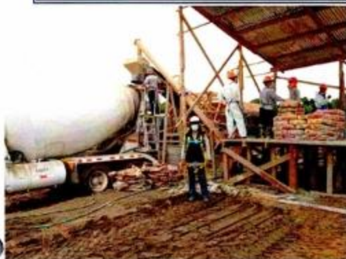
Planta dosificadora de concreto para producción de concreto f_c = 210 \text{ Kg/cm}^2 para losa maciza.
