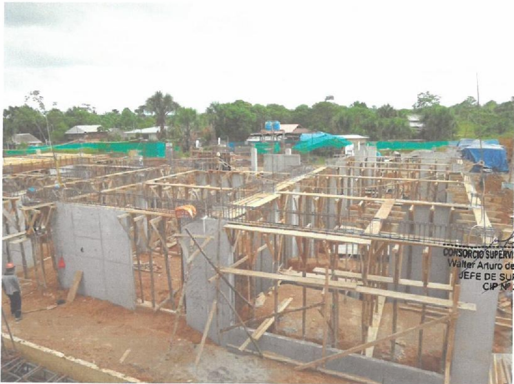
Fotografía N° 08: Encofrado de fondo de vigas peraltadas para losa aligerada en Módulo A-1.
