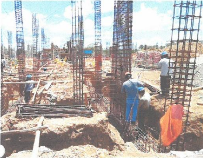
Trabajos de armado de acero en placa y encofrado del mismo en el Bloque C-1.
