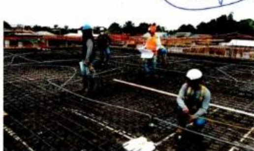
Liberación de losa maciza para vaciado de concreto F_c = 210 \text{ Kg/cm}^2 en Módulo B-1.
