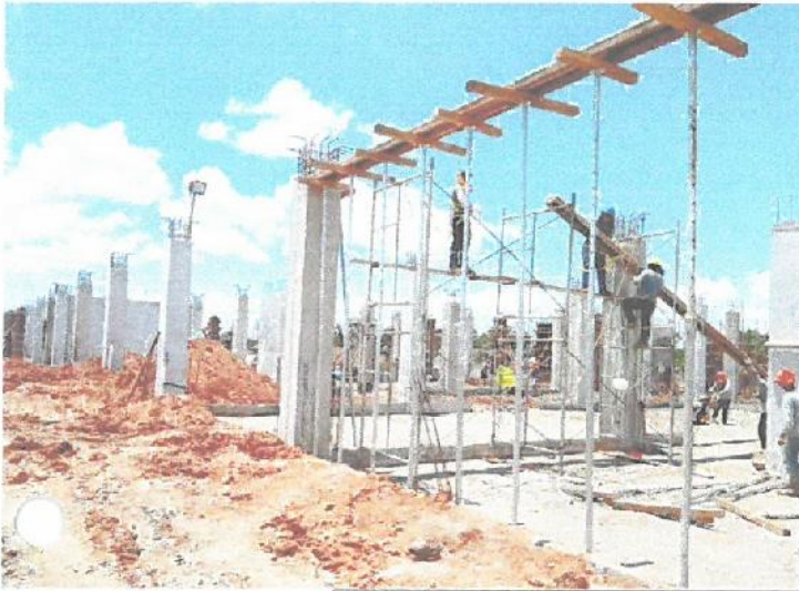
Encofrado de fondo de vigas peraltadas para losa aligerada en el Bloque D - 1ª Parte.
