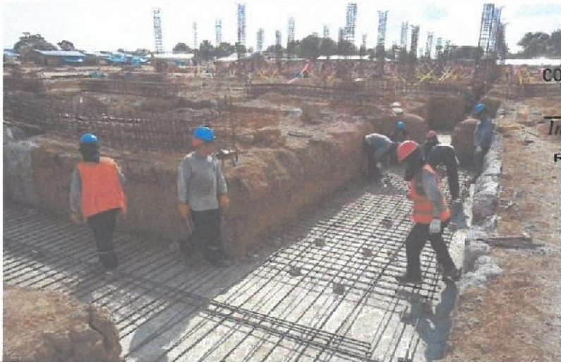
Habilitado de acero estructural en Zapata Combinada con Placas.
