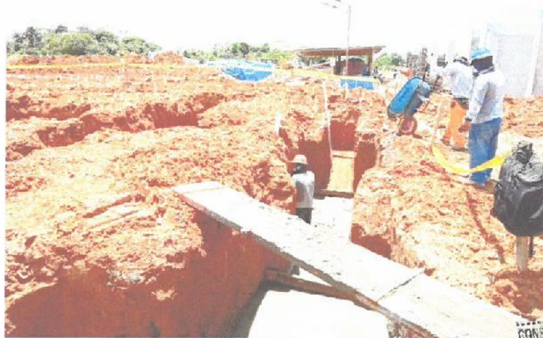
Vaciado de concreto en solados para zapatas y vigas de cimentación en el Bloque F.
