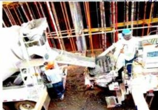
Descarga de concreto de Mixer a Bombe Telescópica para vaciado de concreto en losa maciza.
