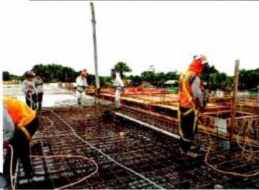
Vaciado de concreto f_c = 210 \text{ Kg/cm}^2 de losa maciza en Módulo D.
