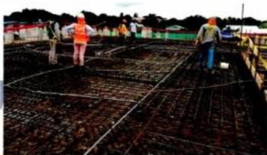
Liberación de losa maciza para vaciado de concreto F_c = 210 \text{ Kg/cm}^2 en Módulo B-1.
