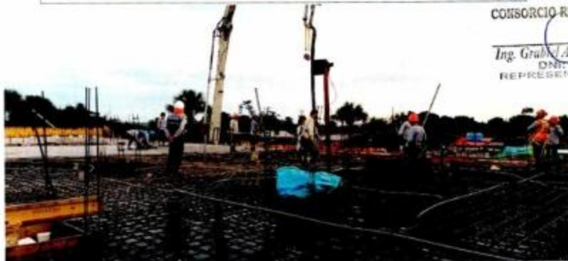
Vaciado de concreto f_c = 210 \text{ Kg/cm}^2 de losa maciza en Módulo D.
