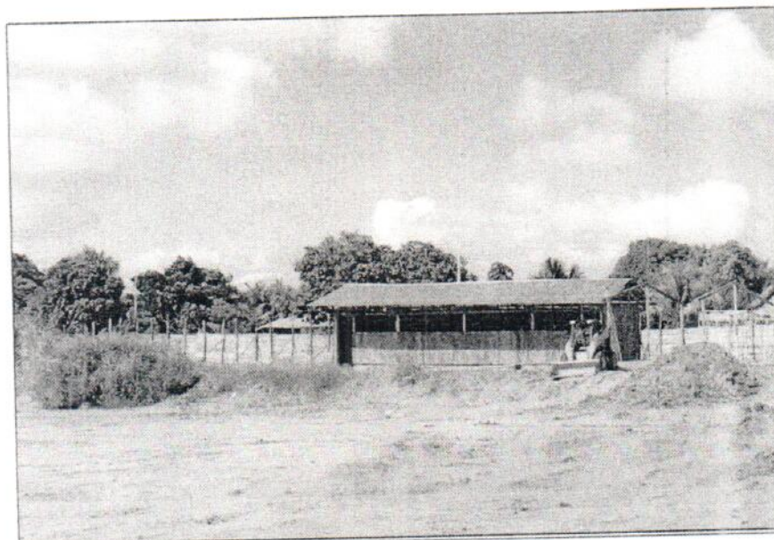
Foto N° 07: Se puede apreciar la caseta de vestuarios del personal
