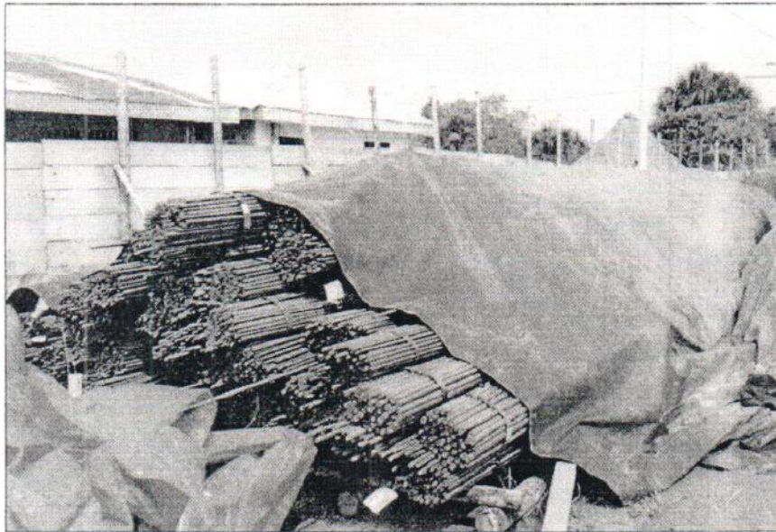
Foto N° 02: Se puede apreciar los acero de refuerzo f_y=4.200 kg/cm 2
