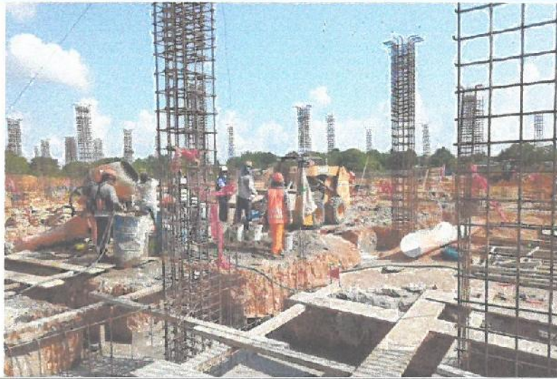
Vaciado de concreto f_c = 210 \text{ Kg/cm}^2 para Zapatas (Bloque D).
