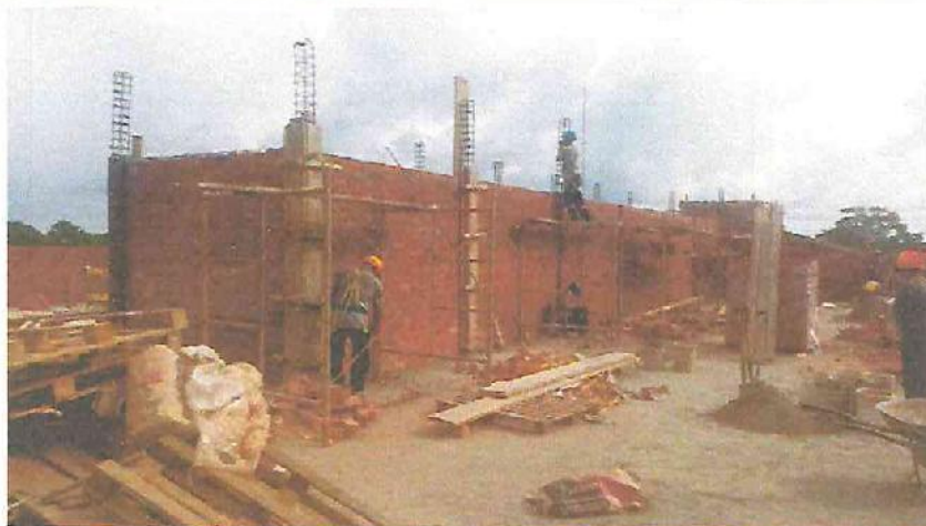
Colocación de acero y Encofrado de columnas en los ductos del Sector A1, Bloque A2.
