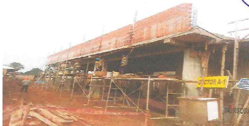
Tarrajeo de cielorraso en voladizo en el Sector A1, Bloque A1.
