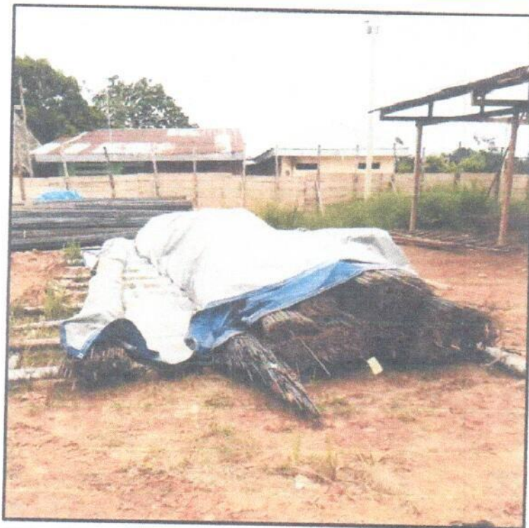
En la vista se observa el acopio y la protección del acero mediante carpas para evitar su corrosión.
