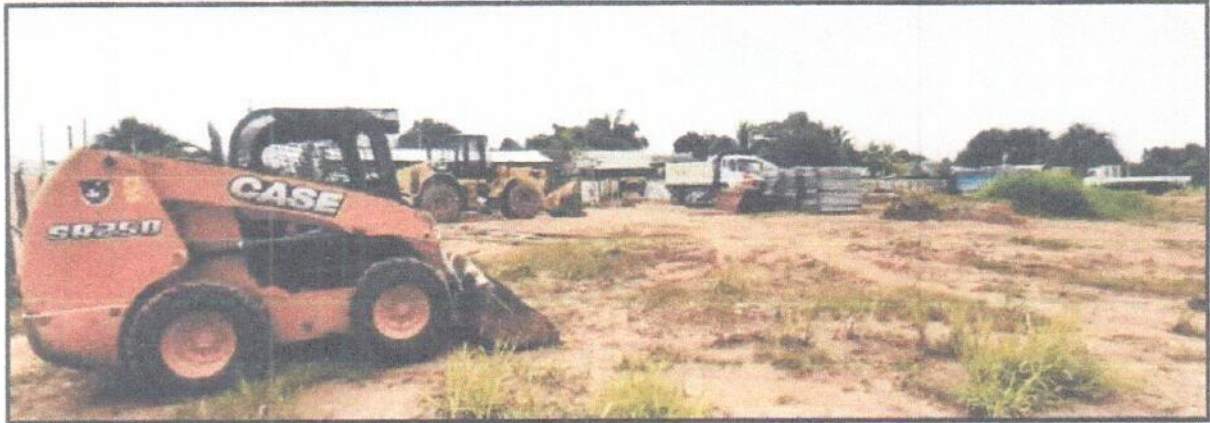
En la vista se aprecia, la maquinaria y los carros que se están usando en obra (Cargador Frontal, Minicargadores, Volquete, Camión.)
