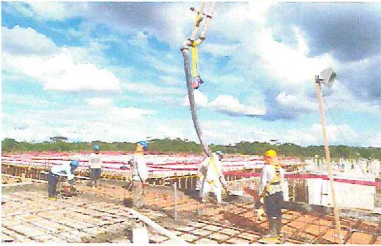
Vaceo de Concreto f'c = 210 \text{ Kg/cm}^2 para losa Aligerada en el Sector C1.
