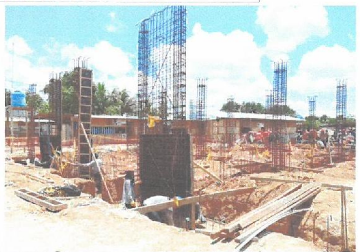
Encofrado de columnas y placas en el Bloque A-1.
