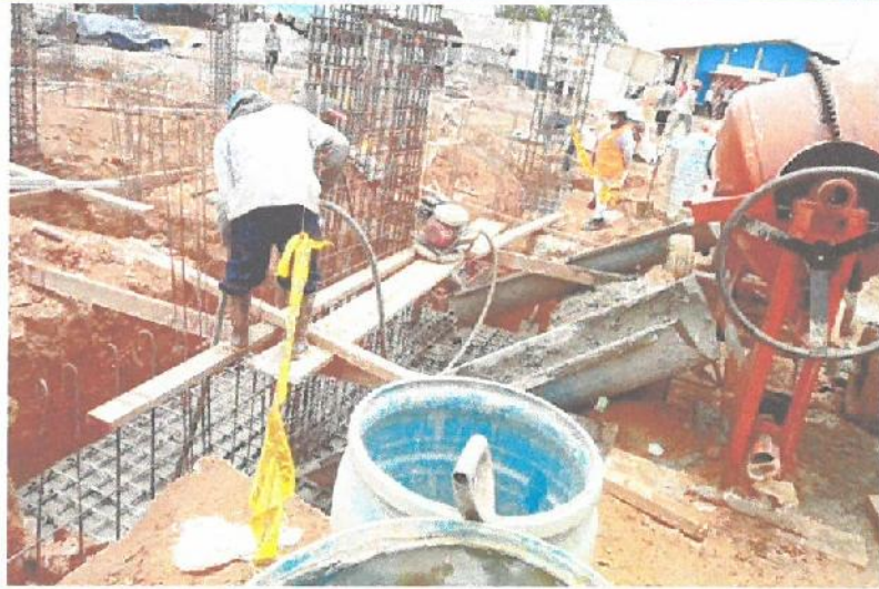
Vaciado de concreto f'c = 210 \text{ Kg/cm}^2 en zapatas en el Bloque A-1.
