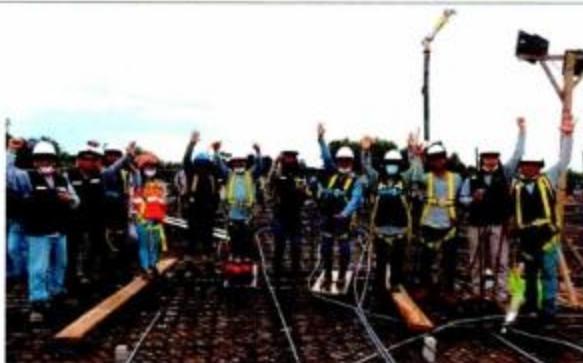
Liberación de losa maciza para vaciado de concreto F_c = 210 \text{ Kg/cm}^2 en Módulo D.
