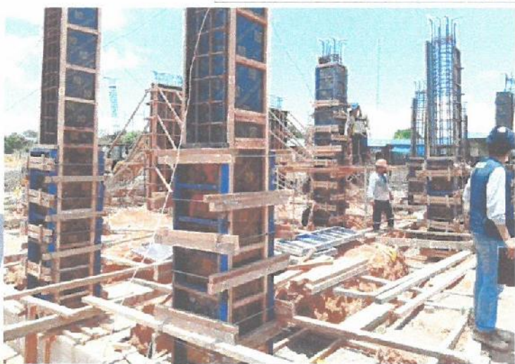
Encofrado de columnas y placas en el Bloque A-1.
