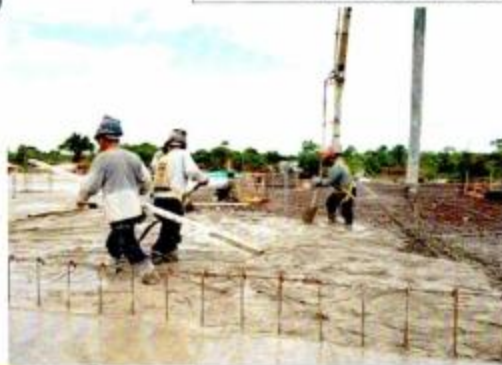
Vaciado de concreto f_c = 210 \text{ Kg/cm}^2 de losa maciza en Módulo D.
