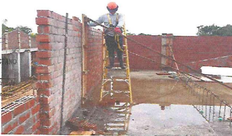
Vaciado de concreto f'c = 175 \text{ Kg/cm}^2 de Columnetas en Módulo D.
