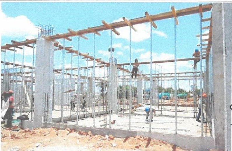
Encofrado de fondo de vigas peraltadas para losa aligerada en el Bloque D - 1ª Parte.
