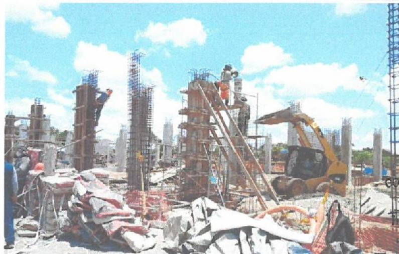
Vaciado de concreto en columnas en el Bloque D - 2° Parte con apoyo de Mini Case.
