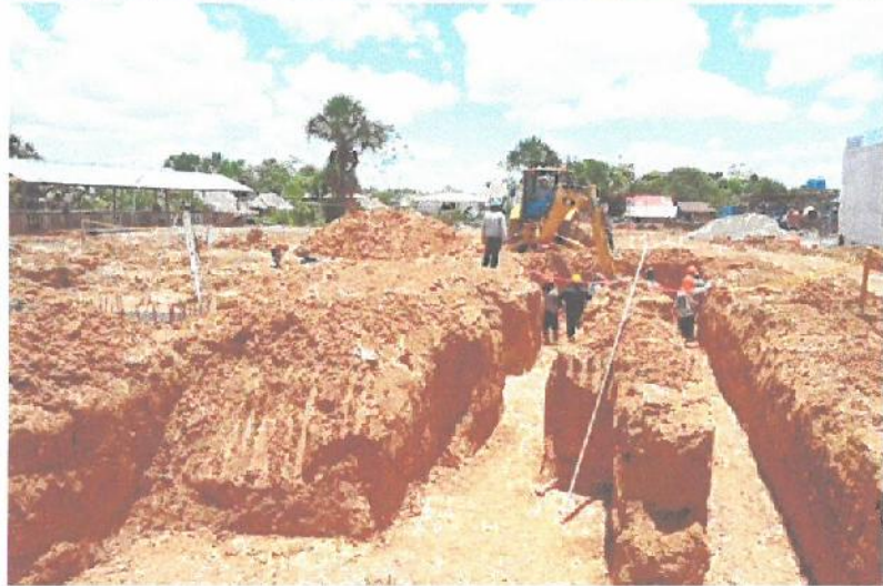
Excavación de zanjas para zapatas y vigas de cimentación en el Bloque A-1.
