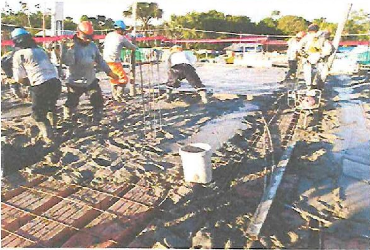
Vaceo de Concreto f'c = 210 \text{ Kg/cm}^2 para losa Aligerada en el Sector C1.
