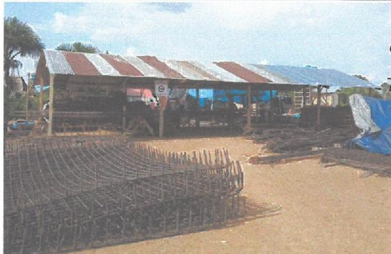
Habilitado de acero estructural para Zapatas y Columnas para los diferentes bloques.
