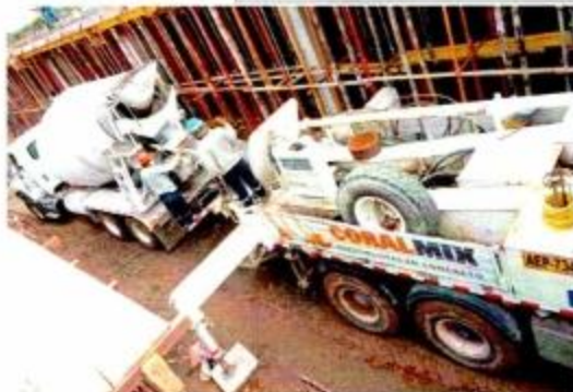
Descarga de concreto de Mixer a Bombe Telescópica para vaciado de concreto en losa maciza.
