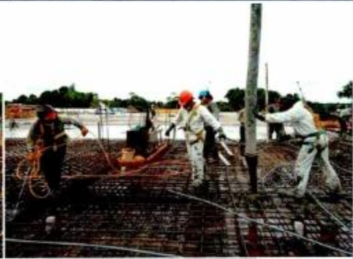
Vaciado de concreto f_c = 210 \text{ Kg/cm}^2 de losa maciza en Módulo D.
