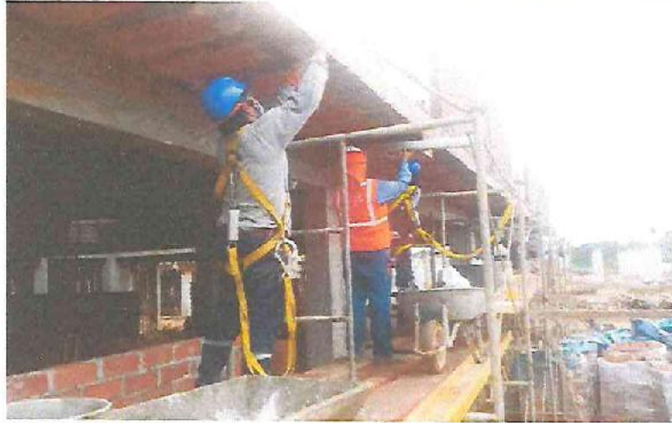
Liberación de tarrajeo en cielorraso de voladizo en el Sector A1, Bloque A1..
