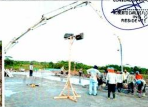
Vaciado de concreto f_c = 210 \text{ Kg/cm}^2 de losa maciza en Módulo D.
