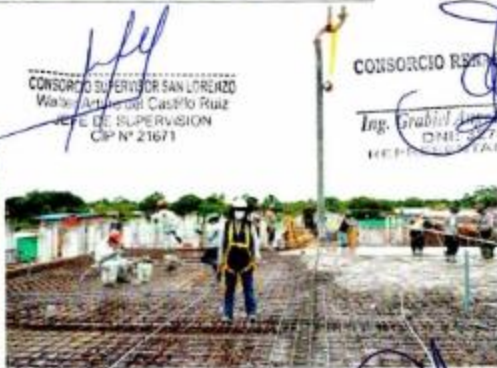
Vaciado de concreto f_c = 210 \text{ Kg/cm}^2 de losa maciza en Módulo D.
